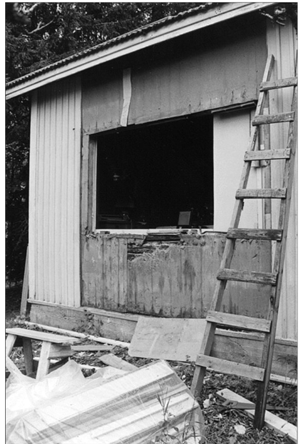
Vanhojen ikkuna-aukkojen avaaminen paljasti seiiniin pitkiä aukkoja. Onneksi hirsiseinä kantaa itsensä.
