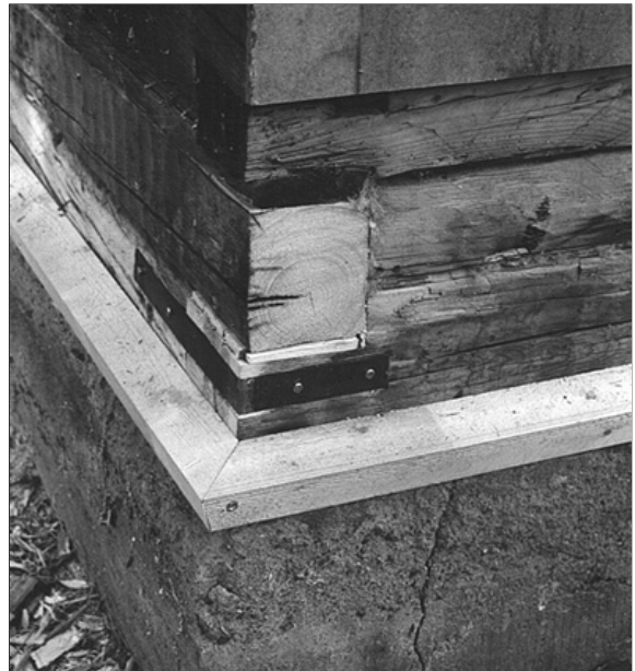
Hirsien liitokset on vahvistettu raudoituksilla.
