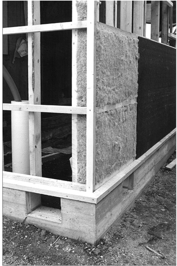
Kuistin seinät on lämpöeristetty pellavalevyillä.
