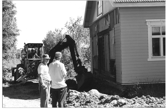
Kaivuri teki hetkessä kuistin pohjatyöt.
