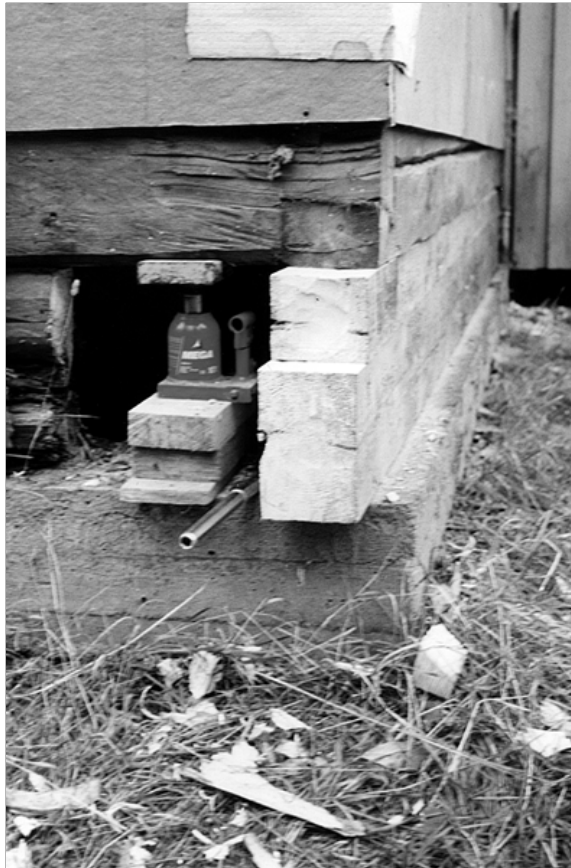
Hirsien nostossa käytettiin 10 tonnin tunkkia.
