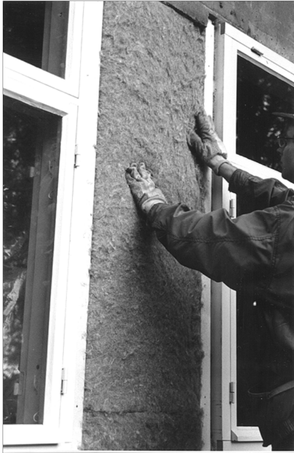
Ikkunoiden välit täytettiin pellavaeristeellä.
