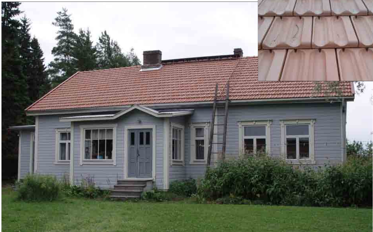
Rakennuksessa on vanhaan tapaan jälleen kaksi sisäänkäyntiä, nimittäin talouskuisti ja lasikuisti. Ulkopinnat maalattiin pellavaöljymaalilla. Vesikatteena ovat pienikokoiset, säädettävät savikattotiilet.
