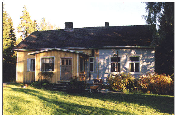
Julkisivuremontti on edennyt talon puoliväliin.
